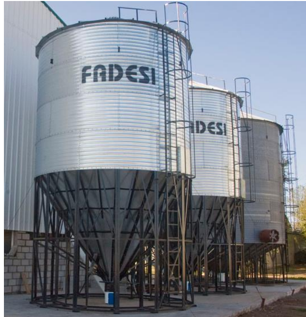
Figura 6.7. – Tanques de almacenamiento de materias primas Fuente: www.mayper.com.ar
