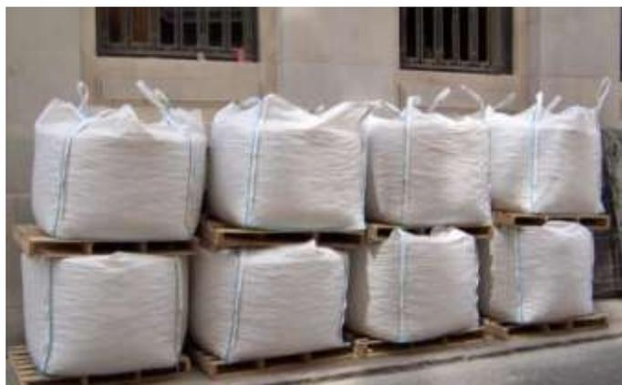
**Figura 6.8** Almacenamiento de RCD en saco de rafia
