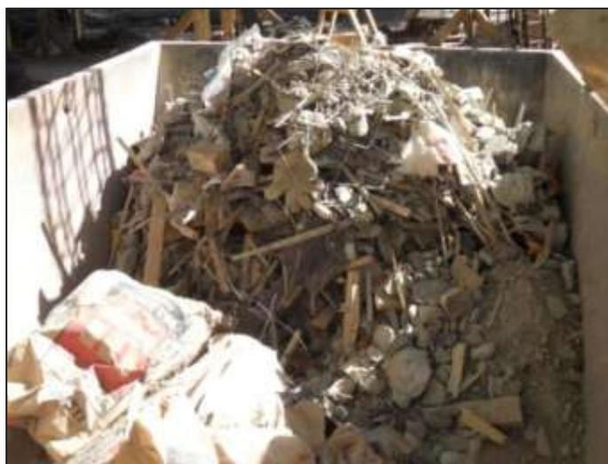
**Figura 6.9** Recogida no-selectiva de RCD
