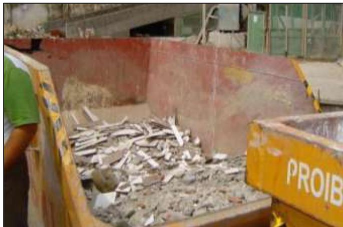
**Figura 6.7** Contenedor de recogida selectiva de residuos inertes
