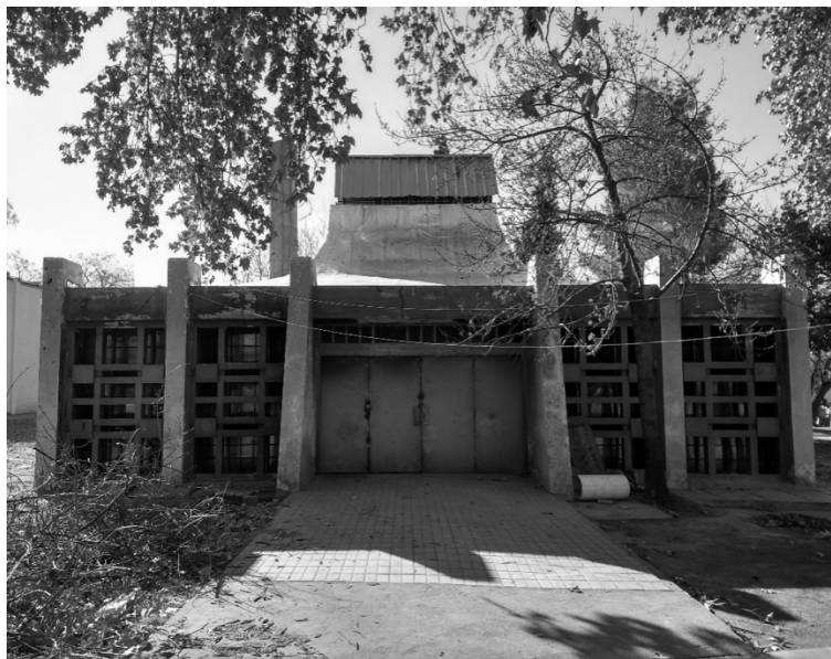
Fig. 7: “Edificio del Crematorio del Cementerio de la Capital de Mendoza” diseñado por la arquitecta Graciela Hidalgo en 1969. Obsérvese su diseño meramente moderno con líneas rectas y el uso del hormigón armado. Asimismo, el diseño de las ventanas realizadas también en hormigón. Actualmente se encuentra en desuso y en estado de abandono.
